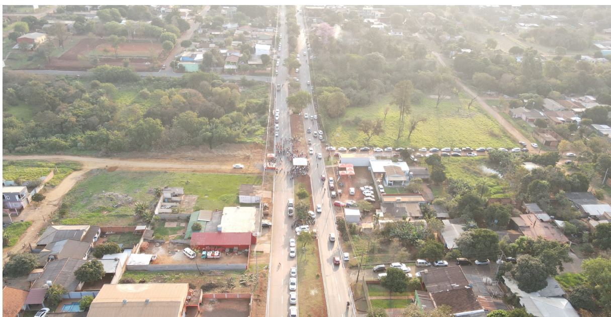
Inauguración de asfalto realizado con la planta Asfáltica Municipal. Fuente: Municipalidad de Ciudad del Este.
