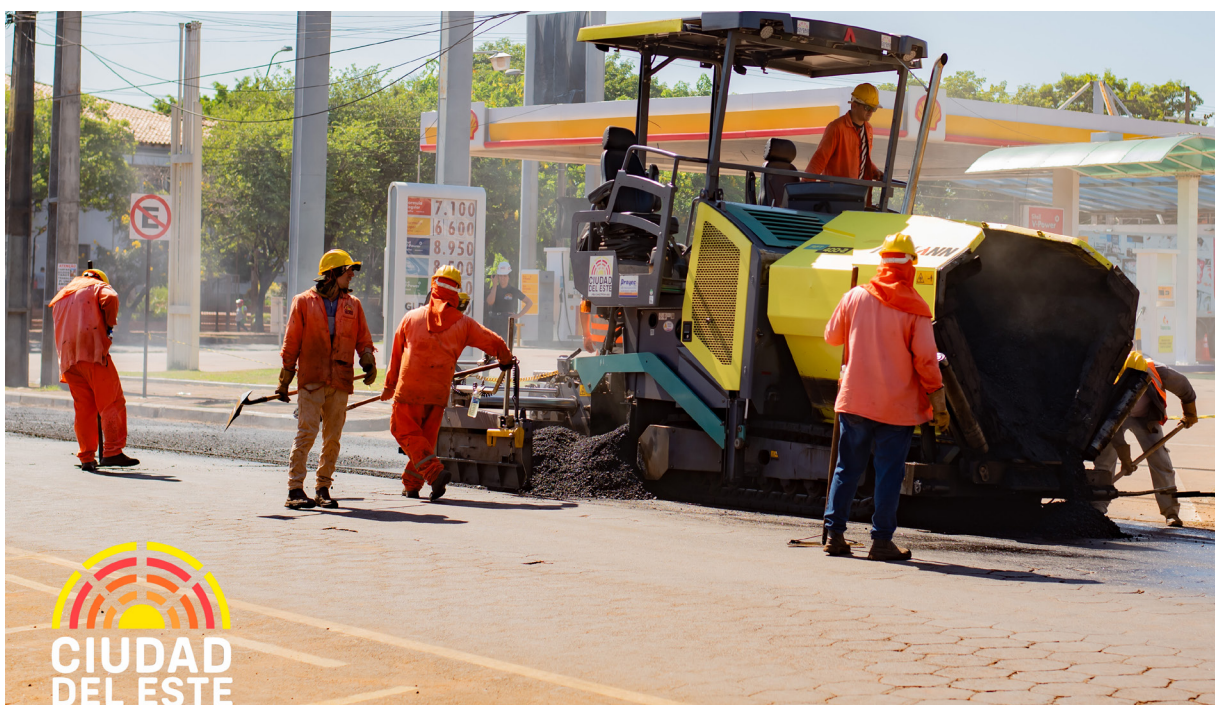
Trabajos realizados por la planta Asfáltica Municipal. Fuente: Municipalidad de Ciudad del Este.
